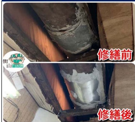
破洞管線修繕
